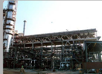
Çelik Konstrüksiyon Montajı
