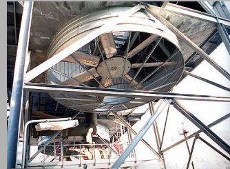
Air Cooler Montajı
