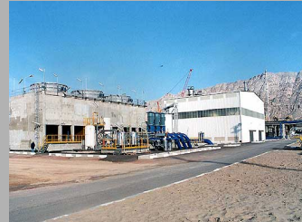
Soğutma Kulesi ve Desalinasyon Ünitesi Montajı
